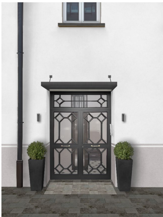
Portone d'ingresso edificio dal cortile
